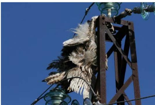
Imagen 1: Búho real electrocutado en torreta con puente flojo y aisladores rígidos.
